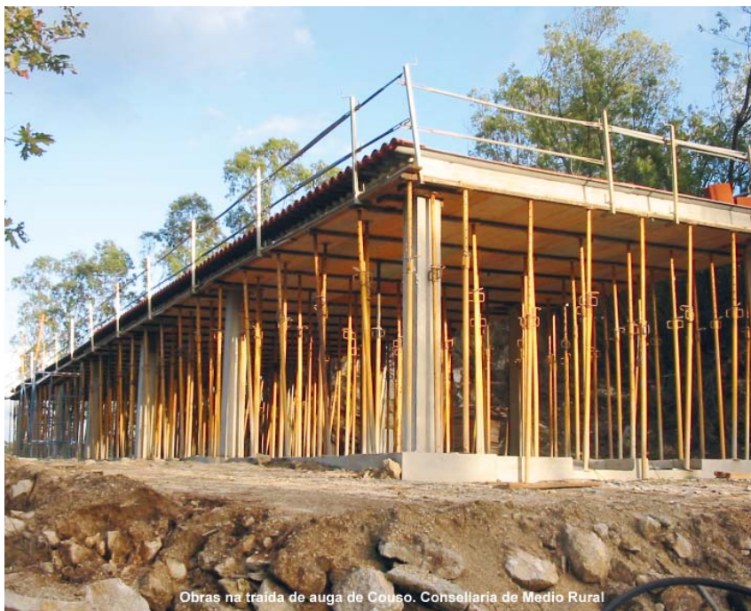
Obras na traída de auga de Couso. Consellería de Medio Rural
